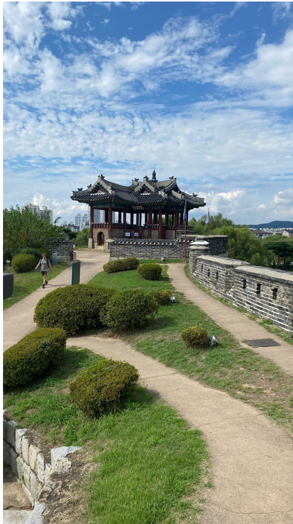
Figure 27 : mur d'enceinte de Suwon
