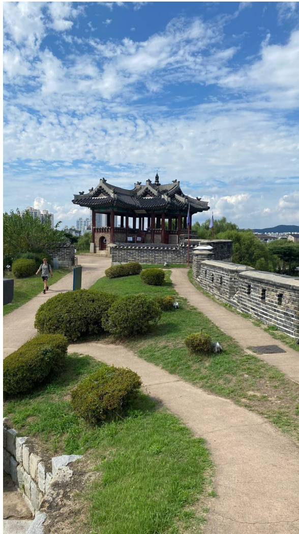
Figure 27 : mur d'enceinte de Suwon
